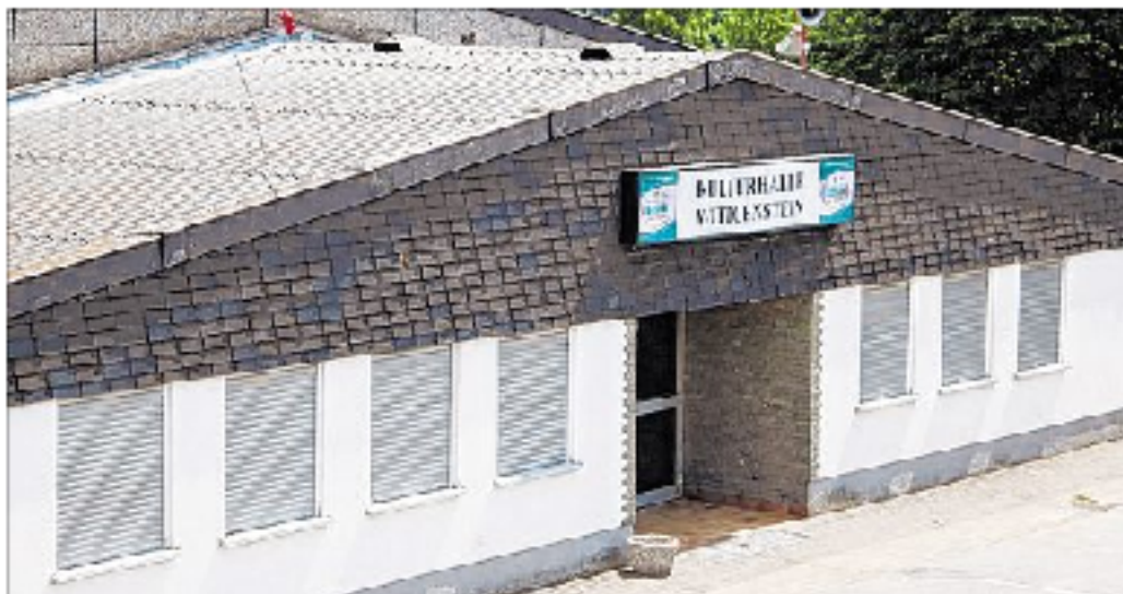
Die Kulturhalle Wittgenstein erfährt eine umfassende Sanierung. Weil hinter dem Projekt eine komplette Dorfgemeinschaft steht, ist es eines von 30 Kandidaten für den Zukunftspreis.
